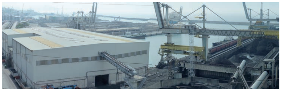
Capannone costruito al posto della vecchia officina consortile "Giaccone"
