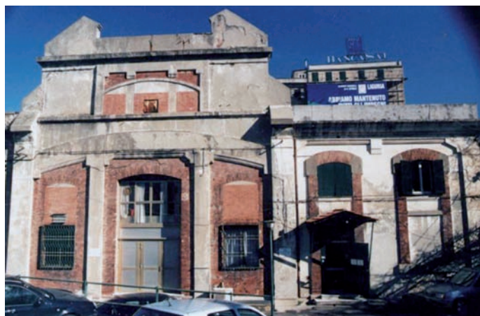
Vecchia sede del Circolo in via di Francia
