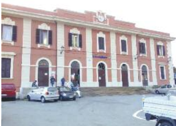
Associazione soleluna sede nella vecchia stazione ferroviaria di Cornigliano
